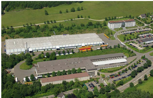
ABUS Kransysteme GmbH, Gummersbach Works
